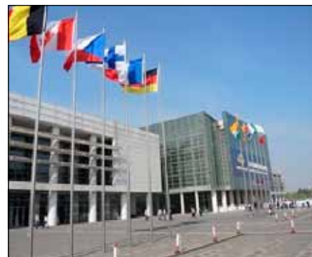
Budovy pekingského výstaviště.
