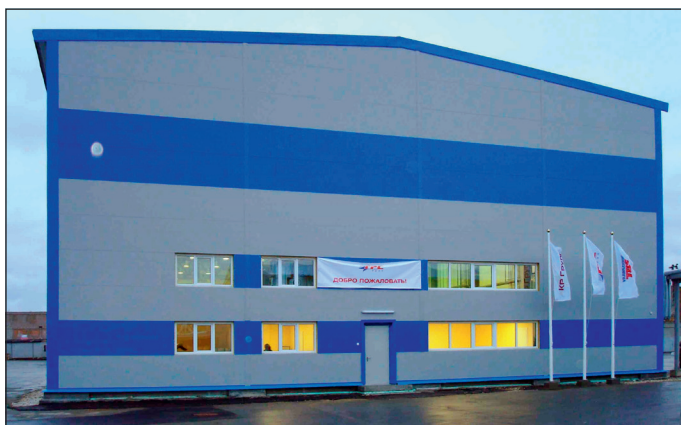
Budova nové montovny v Jekatěrinburgu.
