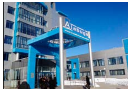
Vstup do prostoru Zvláštní ekonomické zóny Jelabuga
