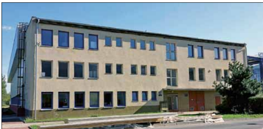
Budova nové školy.
