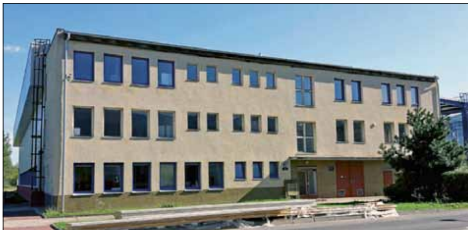
Budova nové školy.
